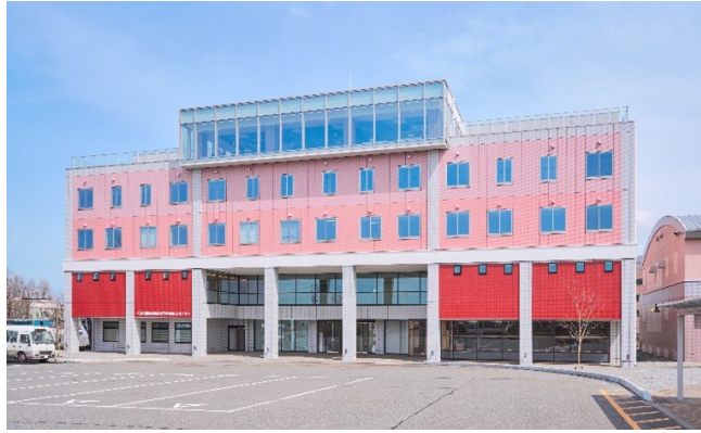
第 11 研究実習棟 (U 棟)
